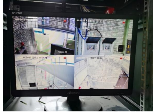
视频监控系统安装与调试
